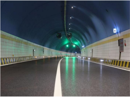
▲ 渭武高速隧道LED照明工程
