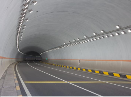
◀ 黄延高速隧道LED照明工程
