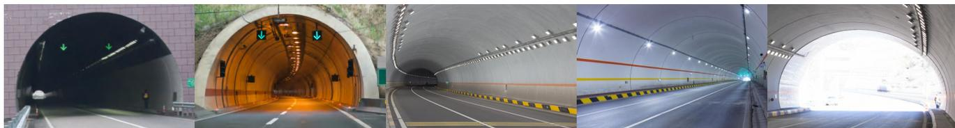
① 注：入口段昼间“黑洞”效应，加强亮度，消除“黑洞”效应，为消除出口处的“白洞”现象，出口段白天亮度一般为中间段亮度的 5 倍，长度在 60m 以上。
