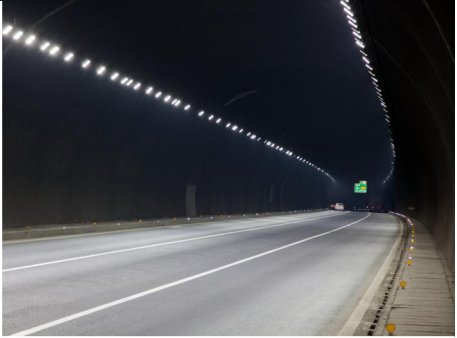
▲ 杭州航天隧道工程
