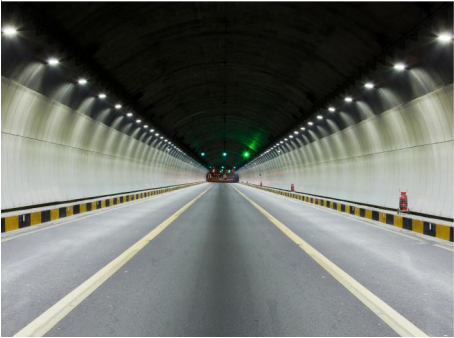
◀ 深高速大梅沙隧道LED照明工程
