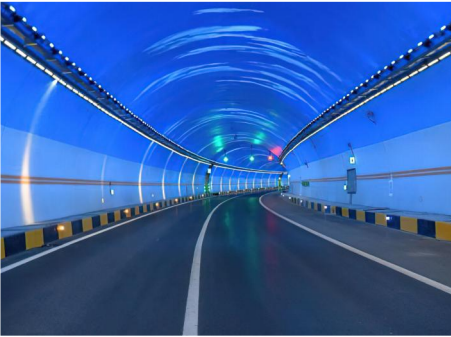
延崇高速隧道LED照明项目 ▶
