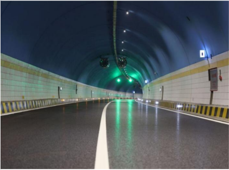
▲ 渭武高速隧道LED照明工程
