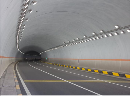
◀ 黄延高速隧道LED照明工程
